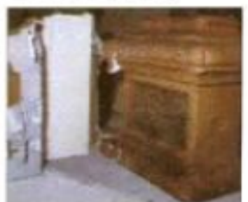
Peintre d'un soulèvement en polyuréthane marouflé.
